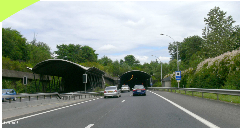
Ecoduc sur l'autoroute Bruxelles-Luxembourg
