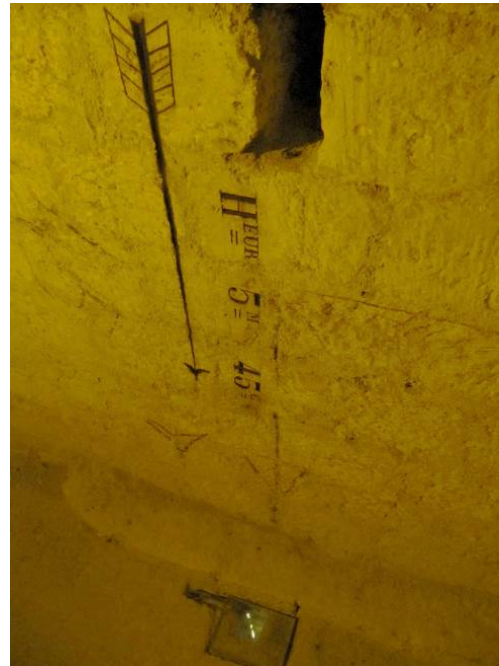
Figure 2. Hauteur maximale d'exploitation du calcaire lutétien dans ce secteur : 5,45 m. (La flèche pointe vers le bas pour montrer l'épaisseur des remblais laissés au cours de l'exploitation).
