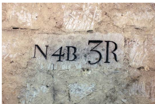
Figures 7 et 8. Graphismes identifiant le 29 e pilier (celui-ci en meulière) érigé en 1777 sous l'Inspectorat de Charles-Axel Guillaumot (d'où la gravure de son initiale « G ») ; et le 4 e pilier (en moellons de calcaire) édifié durant la 3 e année de la République française, sous le contrôle de Bralle « ingénieur hydraulique », Guillaumot étant emprisonné en cette période troublée de l'histoire de France.
